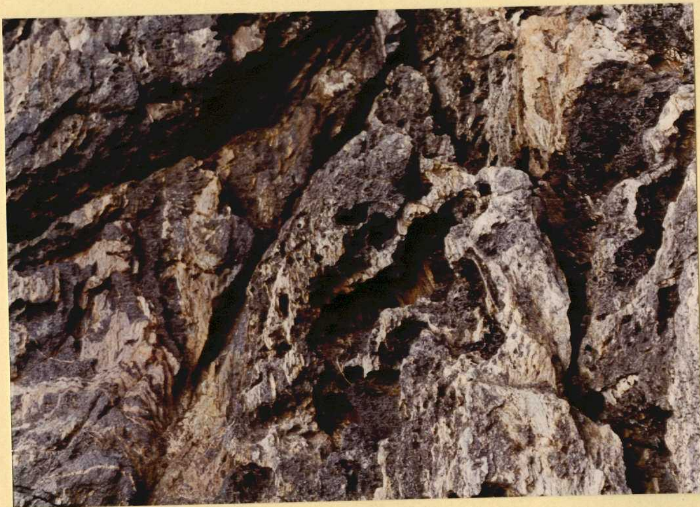
Fenomenos de erosión en los materiales del complejo Cabo d'Home-La Lanzada.
